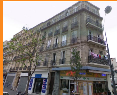
Bâtiment en face de la résidence
