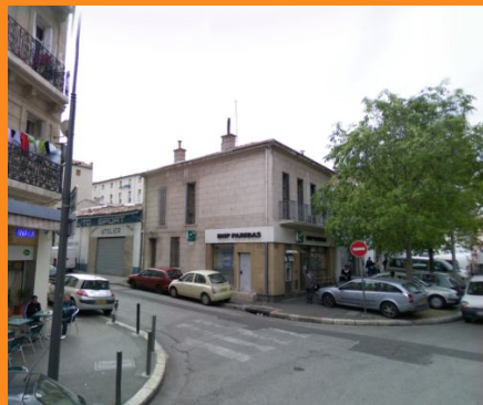
Emplacement résidence- Bâtiment à détruire
