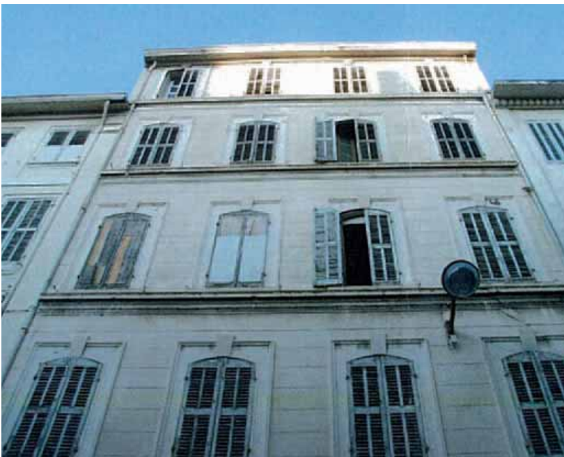
14 rue curiol, partie haute
